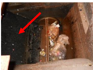
供給コンベアからの落下部。破袋除袋機の羽根車部分にクッションを設置 ③
