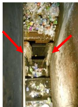
受け入れコンベヤからの乗り換え部の落差 2 m のショックを軽減するためにクッションを設置 ②
