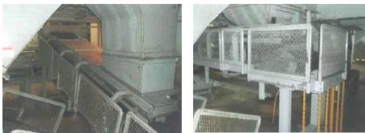
施工前（左）、施工後（右）
