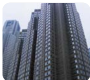
窓ガラス・ガラスウール
