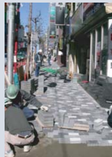
▲第2木期工事施工風景
