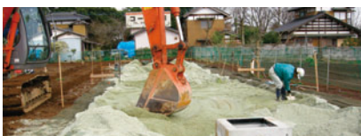
▲貯留浸透工事
