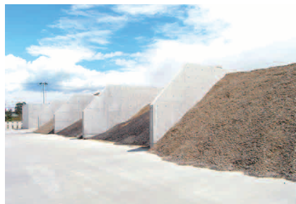
▲ 遠隔地からのカレットを保管するストックヤード(播磨)
