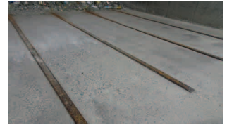
▲ストックヤードに敷かれたレール
